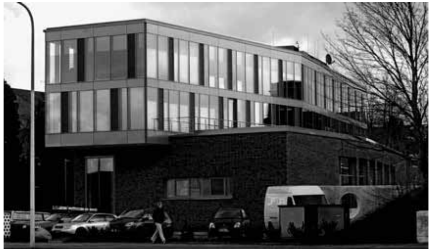
Das Heinrich-Hammer-Institut befindet sich im Haus der Zahnärztekammer Schleswig-Holstein in Kiel. Fotos: Margrit Gehl
