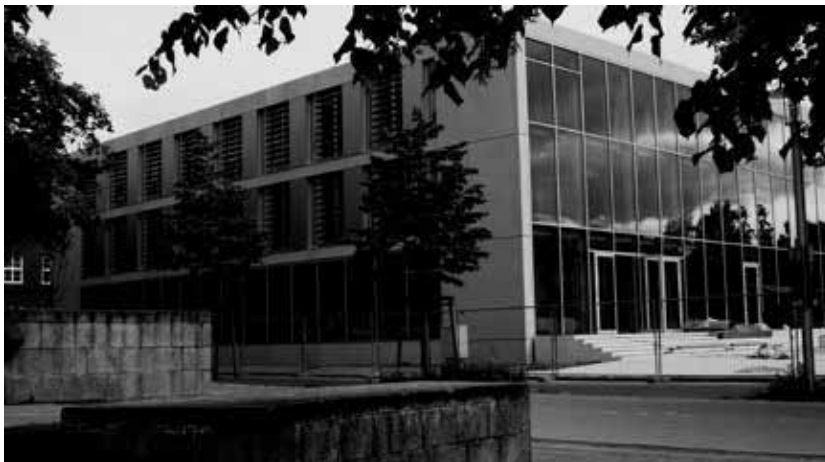
Zu einem Tag der offenen Tür wird in die neue Zahnklinik in Greifswald eingeladen.
